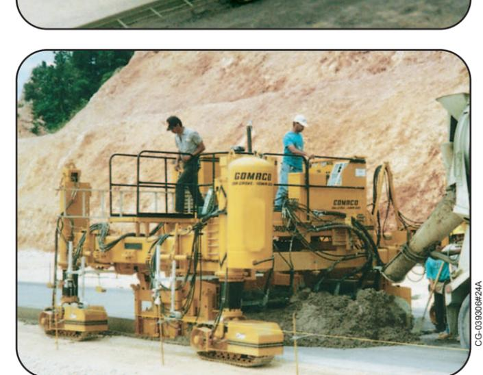
Гусеница с высокорасположенным приводом для производства дорожных работ с минимальным зазором
