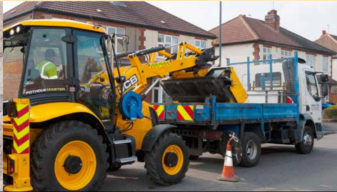
5. УБОРКА | Высыпьте весь мусор в грузовой автомобиль и перейдите к следующей работе.
