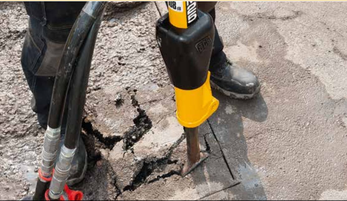
3. ДРОБЛЕНИЕ | Подсоедините ручной гидромолот, чтобы завершить работу и сэкономить время.
