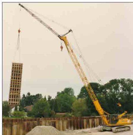
1976 – 1995: гусеничный кран S 1225 с дополнительной стрелой в процессе установки опалубочных панелей
