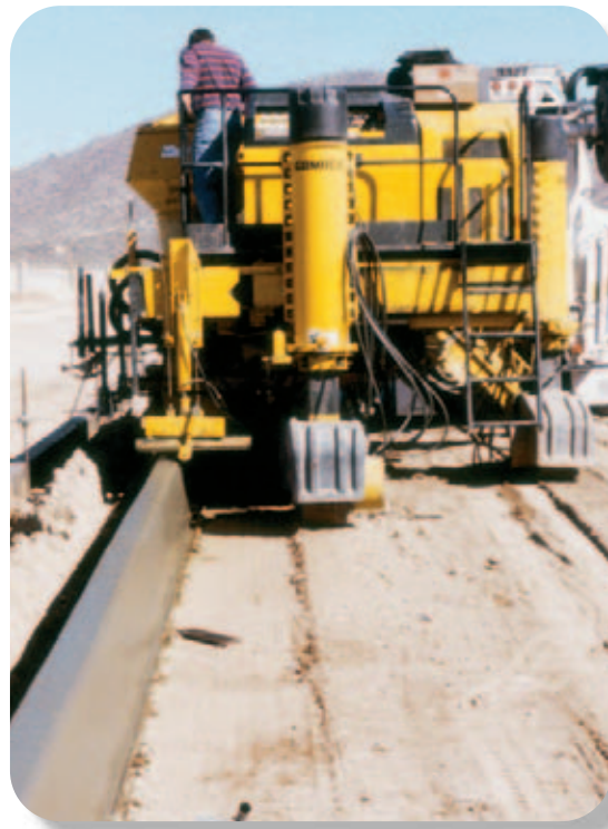
Высокая производительность устройства бетонных конструкций в скользящей опалубке
