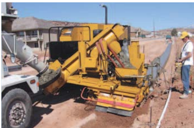
Шнековый питатель с гидравлической регулировкой перемещения до 406 мм опускается для загрузки бетона.
