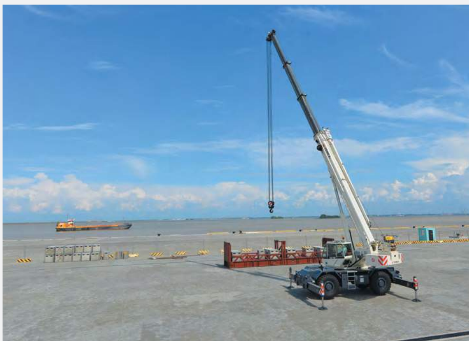
Кран Terex RC45 в зоне погрузо-разгрузочных работ ООО «Феникс»
