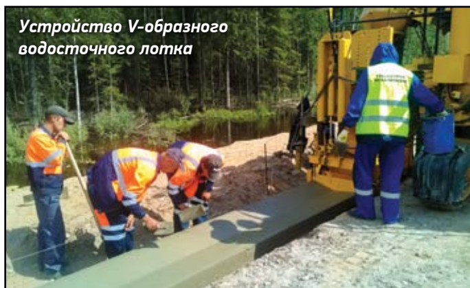
Подача бетона перегружателем при применении передовой европейской разработки устройства щелевого дренажа
