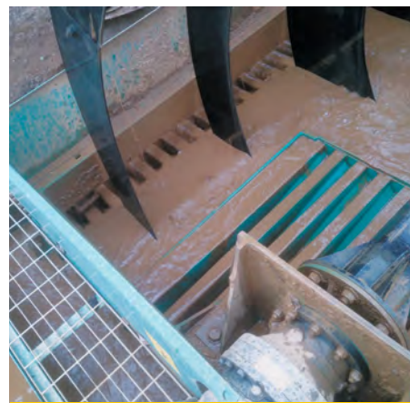
На фото: пульпа и переливы внутри установки T150.
