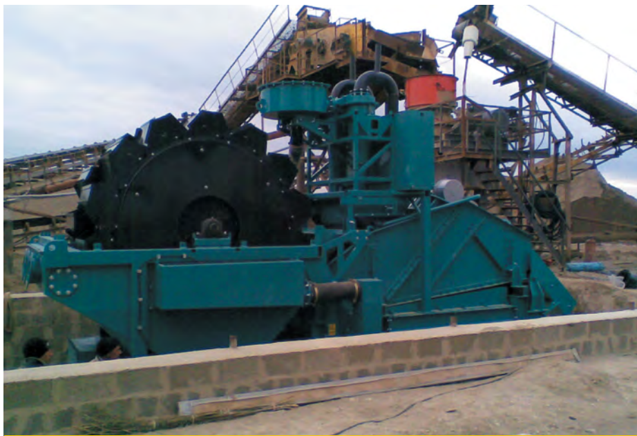
На фото окончание монтажа TWS FM120BW на действующем дробильно-сортировочном заводе ООО «Экспресс».
