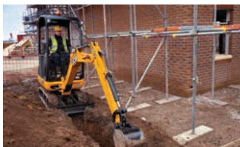
Контролируемая, точная и сбалансированная работа экскаватора.
