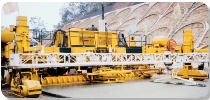
Четырехгусеничный бетоноукладчик GHP-2800 на строительстве новой дороги в Китае. Модульная конструкция рамы обеспечивает ее выдвижение в каждую сторону на 1,98 м, увеличивая общую ширину рамы машины на 3,96.
