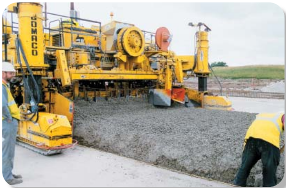
При строительстве аэропорта в Манчестере, Англия, для распределения малоподвижной бетонной смеси в передней части бетоноукладчика GHP-2800 был установлен плужковый распределитель. Его можно устанавливать как на двух-, так и на четырехгусеничной машине GHP-2800.
