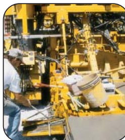
Концевая форма с ручным внедрением L-образных штырей.
