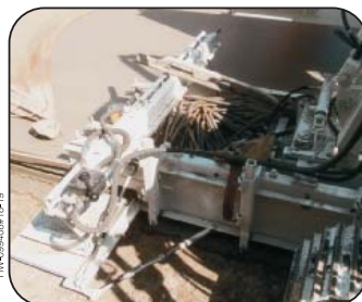
Концевая форма с пневматическим внедрением L-образных штырей.
