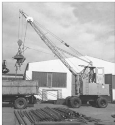
1962 г.: модель S833 с канатной системой и приподнятым расположением кабины
