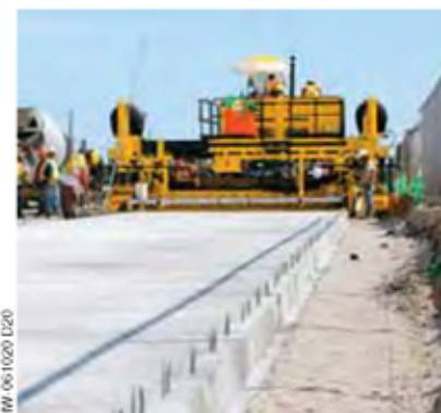
Бетоноукладчик GP2400 способен вести укладку в скользящей опалубке в условиях ограниченного пространства.
