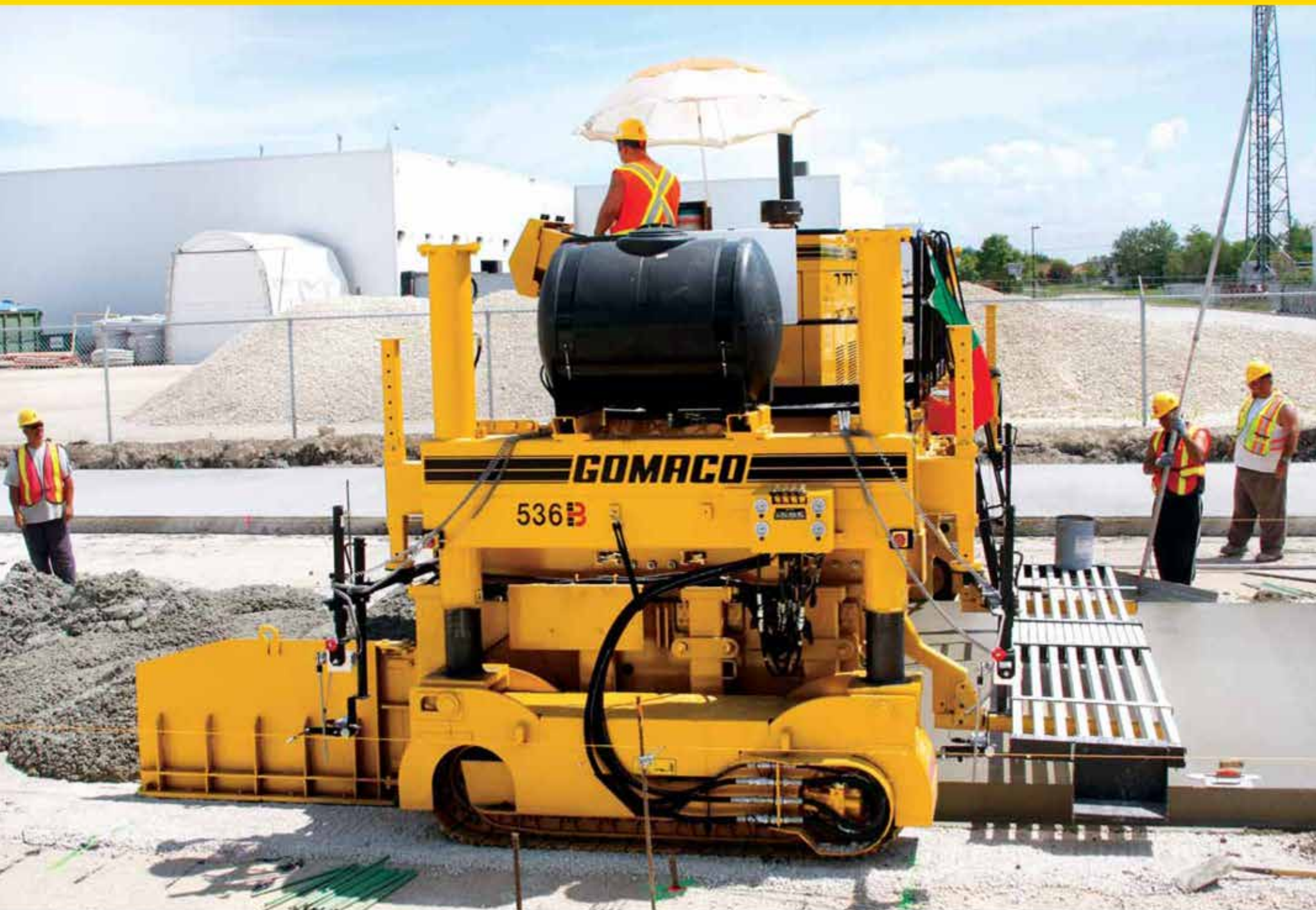
Двух-гусеничный бетоноукладчик GP2400 (ширина покрытия 5 м, толщина 203 мм) в проекте строительства автостоянок в Канаде
