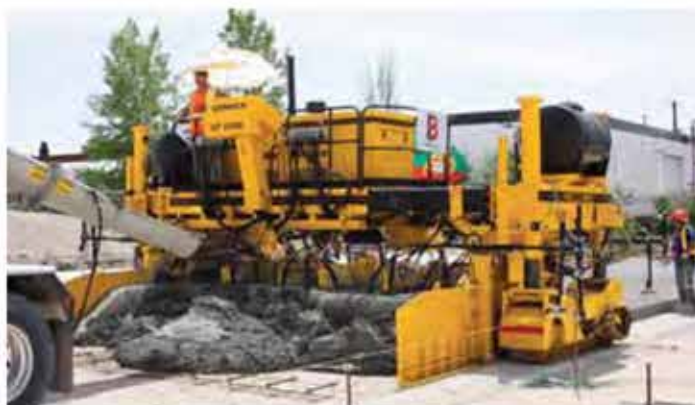
Платформа оператора обеспечивает хороший обзор процесса укладки.
